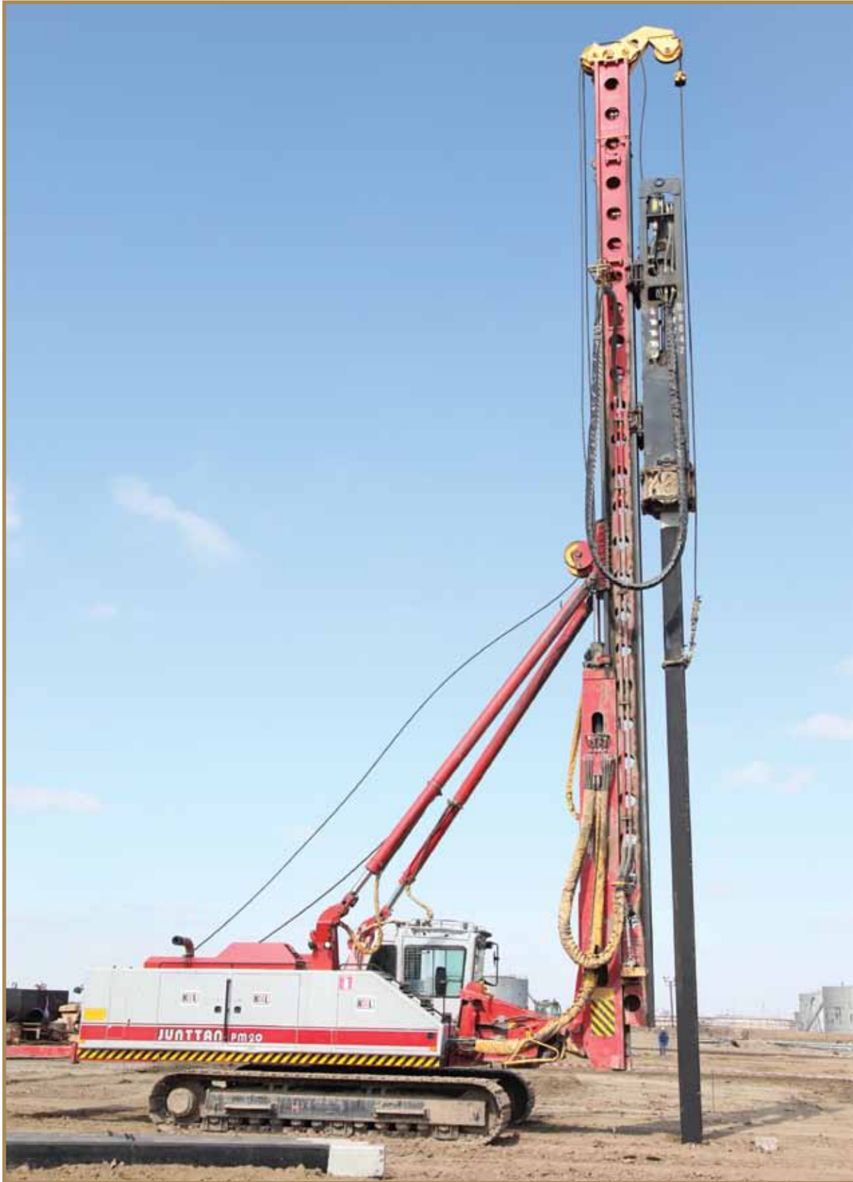
Ароматты көміртектер өндіру кешені құрылысының алғашқы қадасы Первая свая на строительстве комплекса по производству ароматических углеводородов First pile at the construction of Aromatics Production Plant
