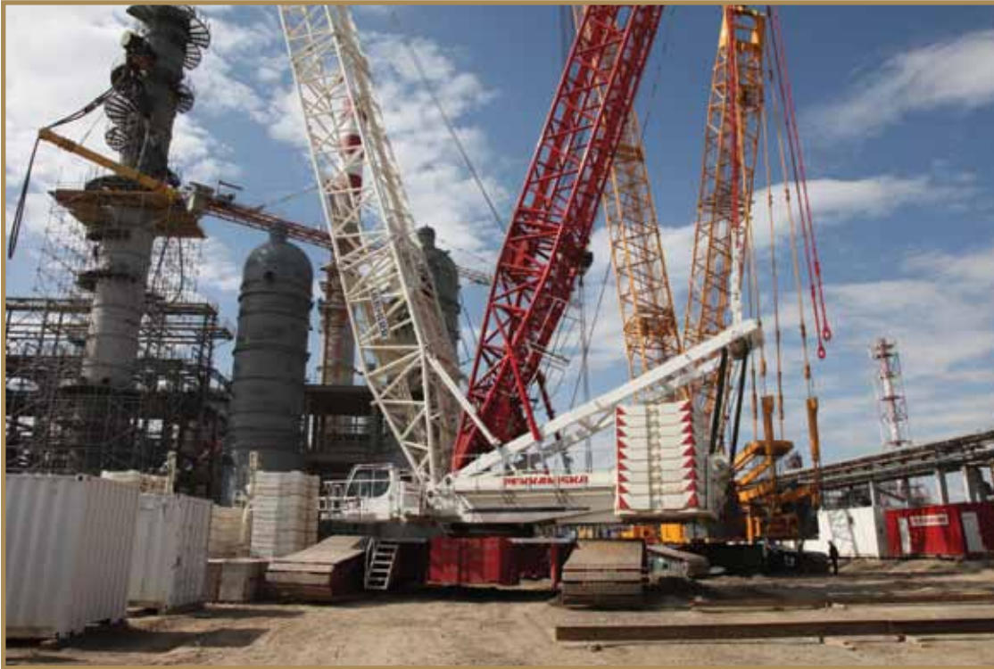
АКӨК құрылысы Строительство КПА Aromatics Production Plant construction
