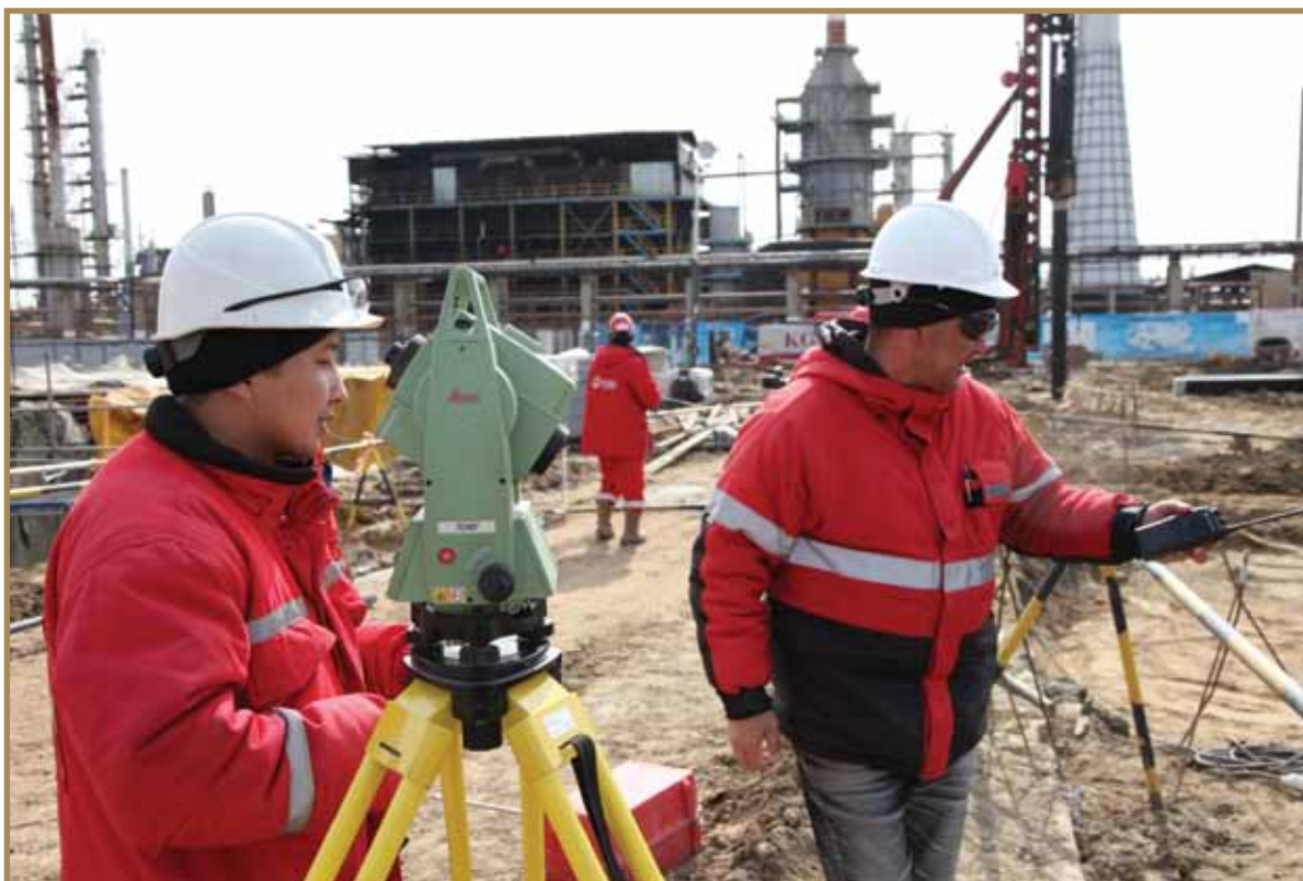
Құрылыс алаңы. 2012 ж. Строительная площадка. 2012 г. Construction site. 2012
