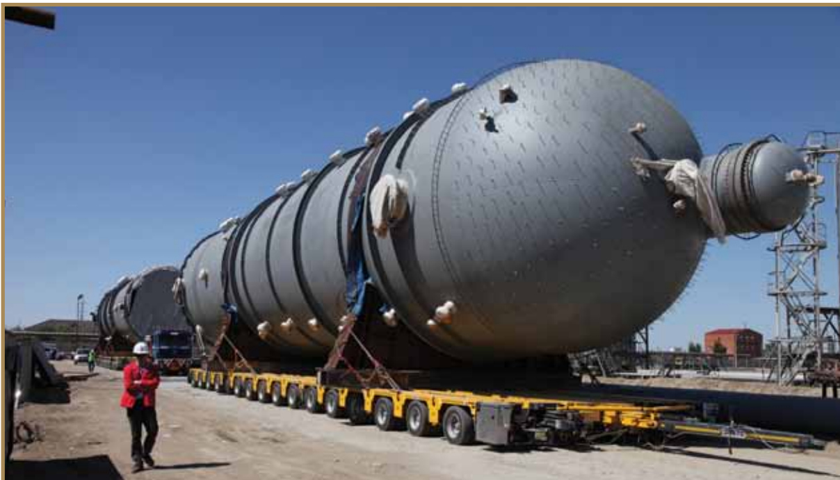
Бағанды жеткізу. 2014 ж. Поставка колонны. 2014 г. Column delivery. 2014
