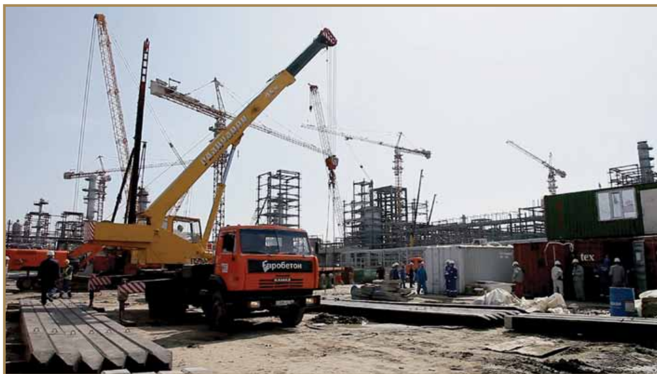
Құрылыс жұмыстары жүруде. Қыркүйек 2015 ж. Идут строительные работы. Сентябрь 2015 г. Construction work. September, 2015
