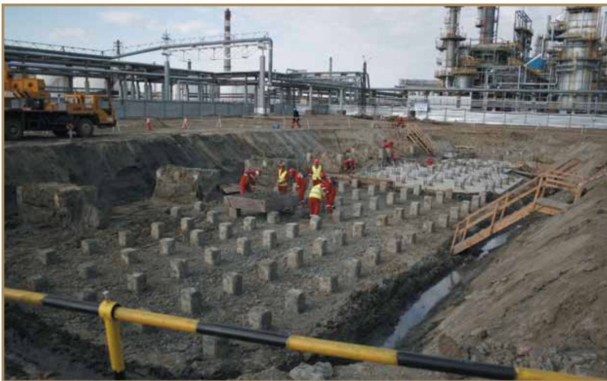
Кешен құрылысы. 2011 ж. Строительство комплекса. 2011 г. Aromatics Production Plant construction. 2011
