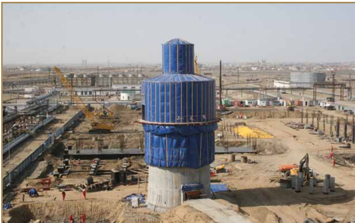
Құрылыс алаңы. 2012 ж. Строительная площадка. 2012 г. Construction site. 2012
