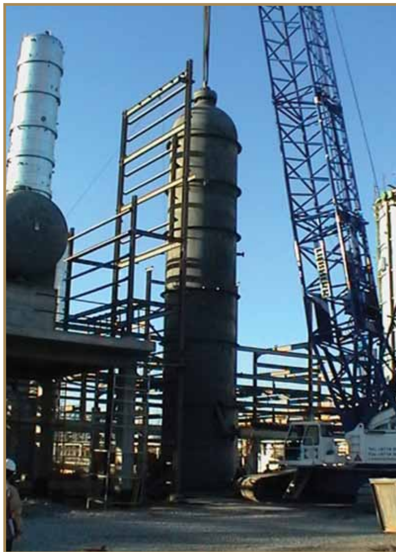
Бағандарды монтаждау Монтаж колонн Columns assembly
