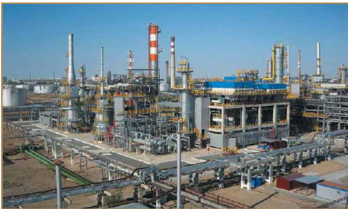
Бензинді гидротазалау және дизель отынын парафинсіздендіру қондырғысы Установка гидроочистки бензина и депарафинизации дизельного топлива Naphtha Hydrotreater and Diesel Fuel Dewaxing Unit
