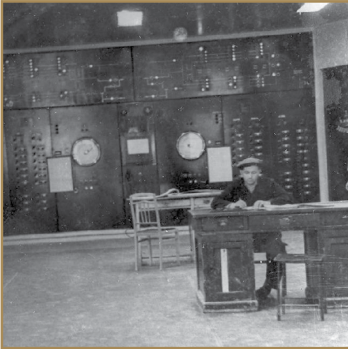
Каталитикалық крекинг қондырғысын басқару қалқаны Щит управления установки каталитического крекинга Control panel of Catalytic Fluid Cracking Unit
