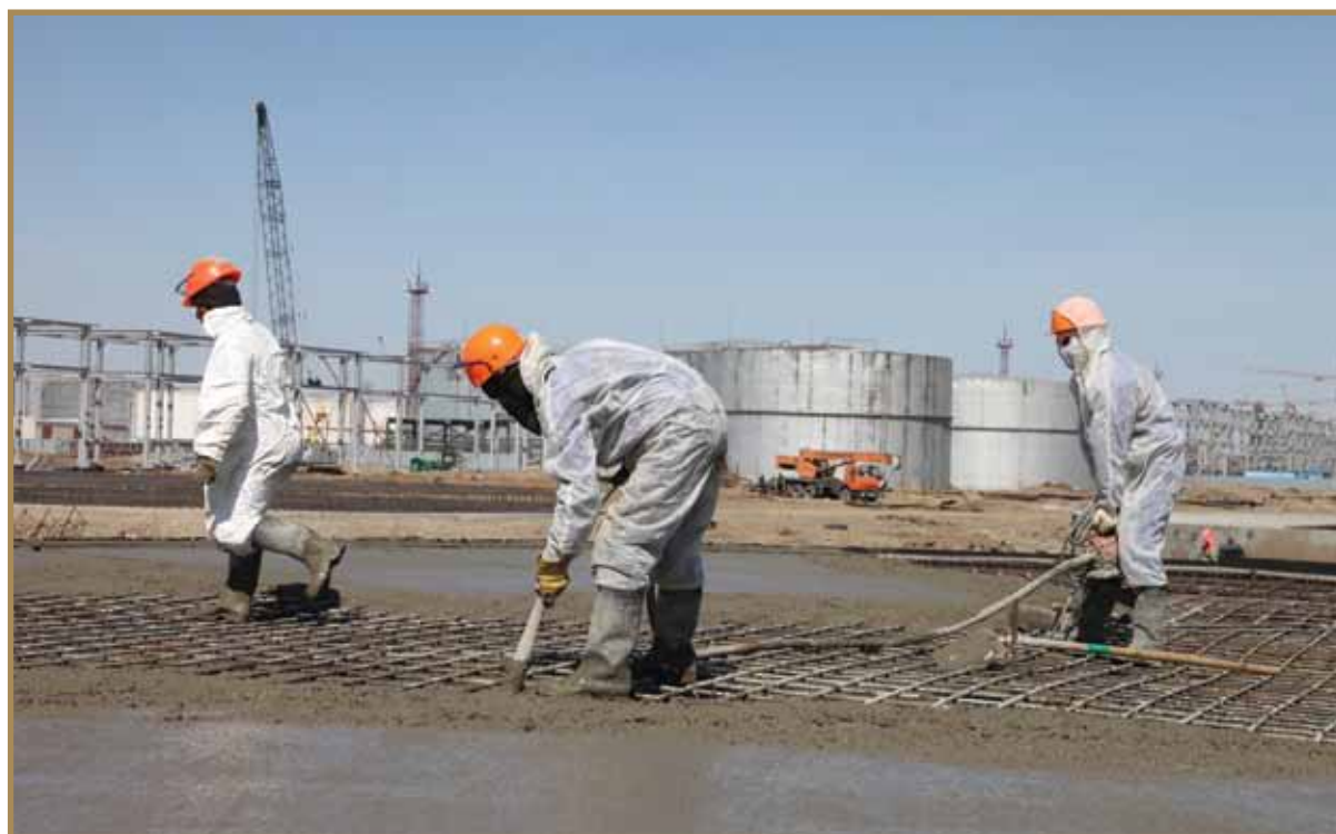
МТӨК алаңындағы құрылыс жұмыстары Строительные работы на площадке КГПН Deep Oil Conversion Complex construction
