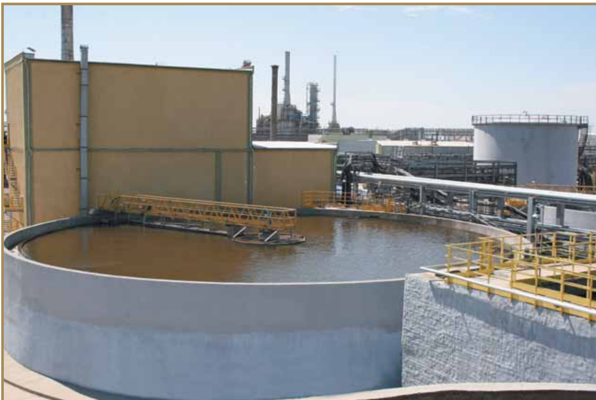
Ағын суларды биологиялық тазалау қондырғысы Установка биологической очистки сточных вод Biological Waste Water Treating Unit
