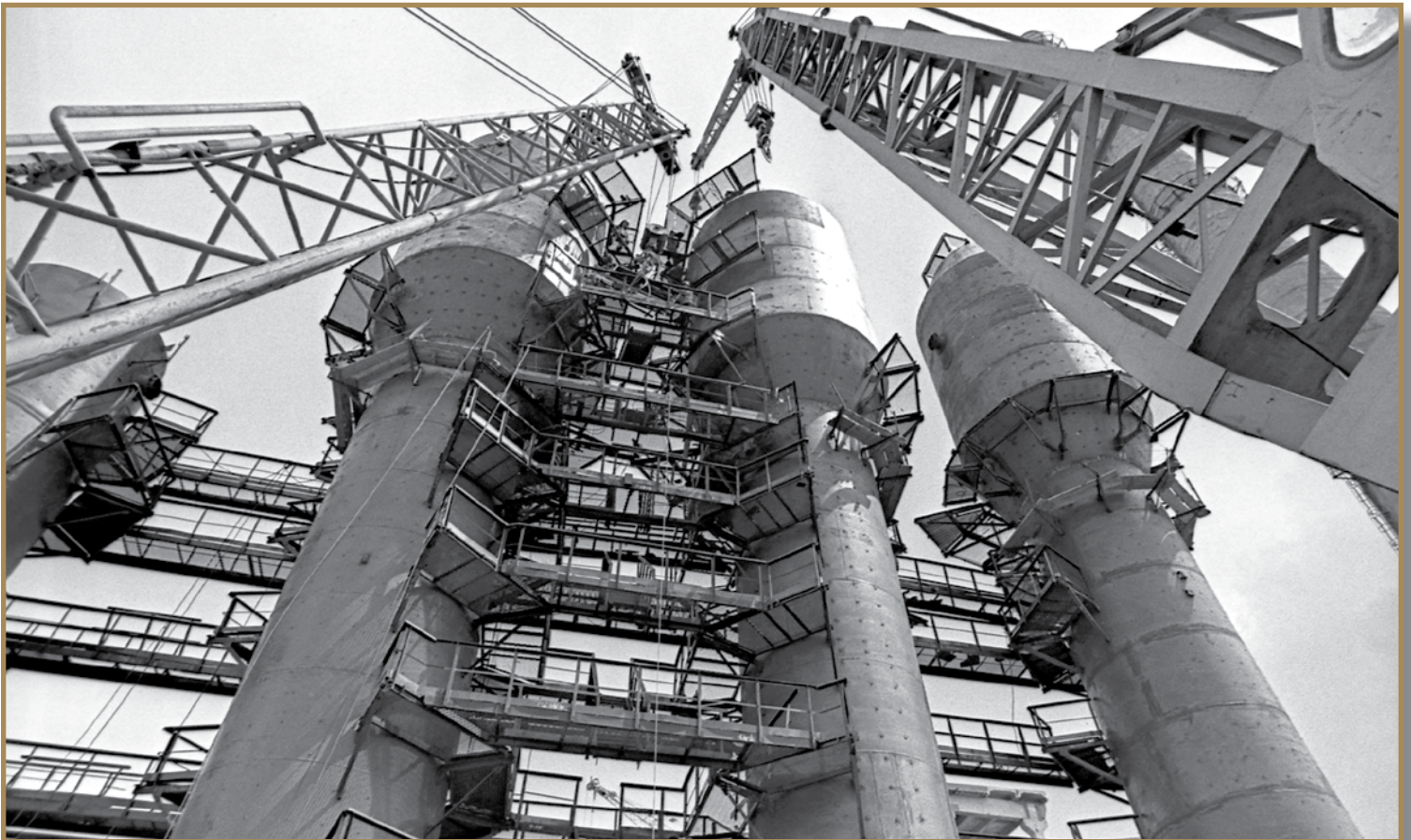
Қондырғы құрылысы Строительство установки Processing facility construction
