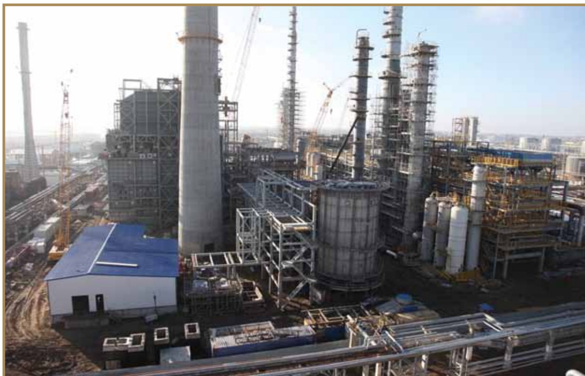
АКӨК құрылысы Строительство КПА Aromatics Production Plant construction
