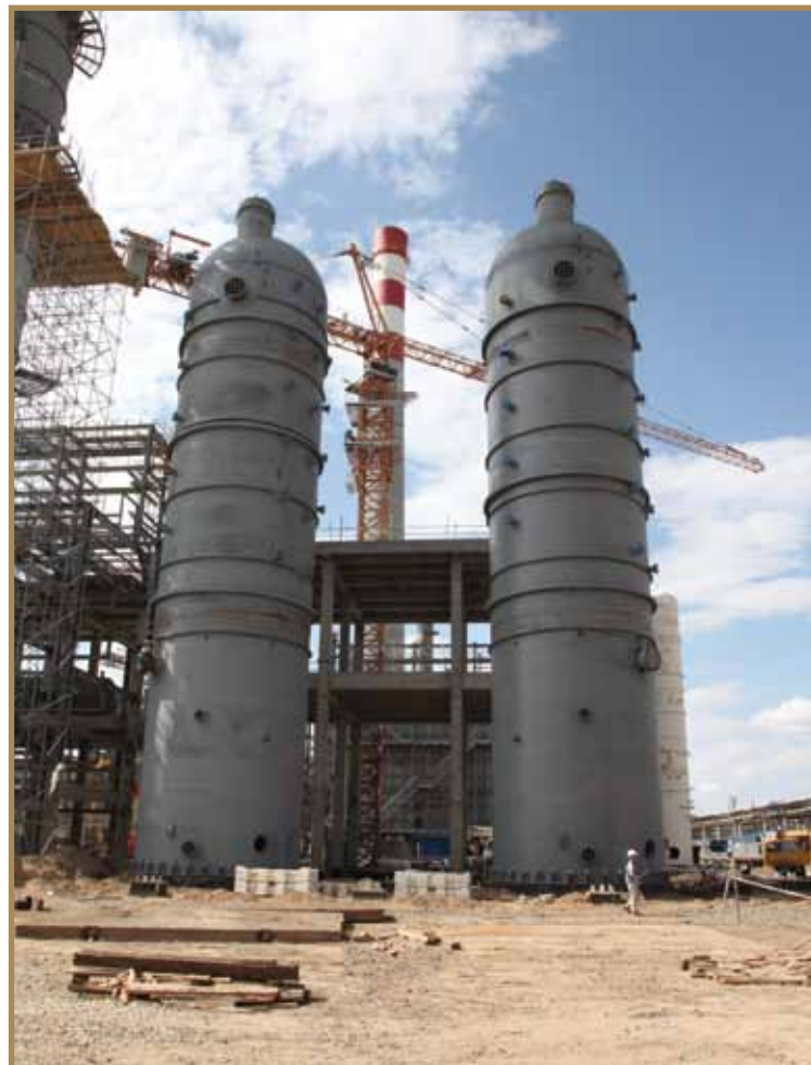
АКӨК құрылысы Строительство КПА Aromatics Production Plant construction
