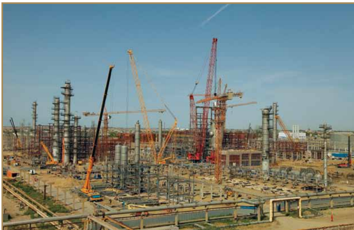
Каталитикалық крекинг қондырғысының құрылысы. Қыркүйек 2015 ж. Строительство установки каталитического крекинга. Сентябрь 2015 г. Catalytic Cracking Unit construction. September, 2015
