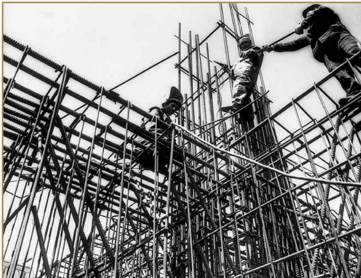
Болашақ кокс цехы ғимаратының арматурасын орнату сәті Монтаж арматуры будущего здания коксового цеха Fitting the future building of Coke Department
